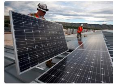
โครงการผลิตไฟฟ้าจากพลังแสงอาทิตย์ ที่ติดตั้งบนหลังคา สำหรับภาคประชาชน
